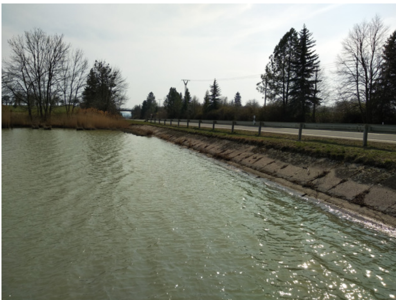
Hráz rybníka Zásadník – korunu tvoří komunikace I. třídy č.32
