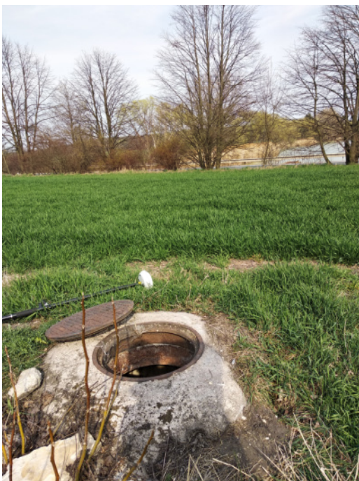
Revizní šachta zatrubnění odpadního potrubí z požeráku na zemědělském pozemku
