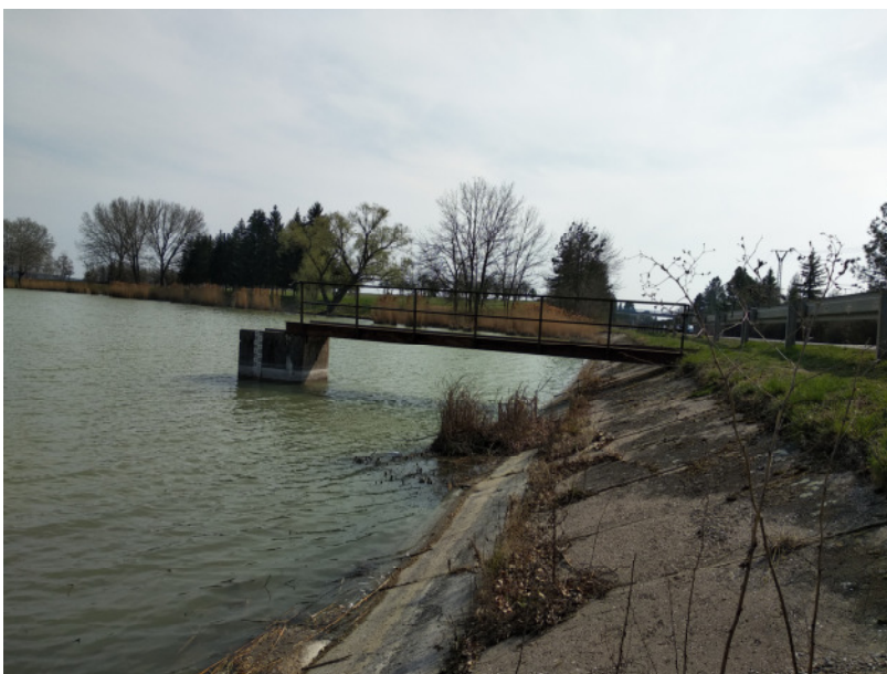
Požerák s ocelovou lávkou
