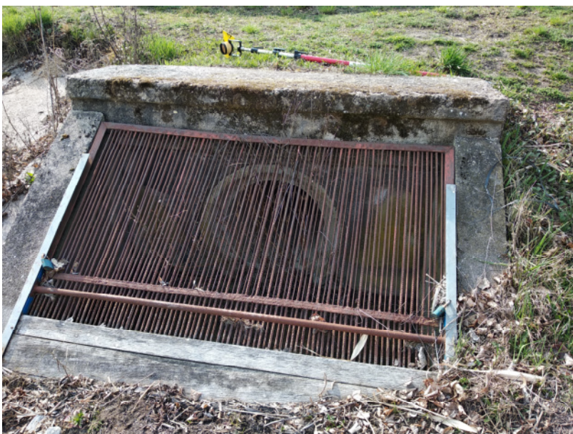
Trubní propust s česlemi v návodním svahu hráze
